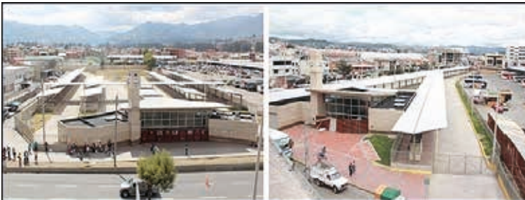
Fotografía 3: Terminales de transferencia sector noreste y suroeste Fuente: www.eltiempo.com.ec
