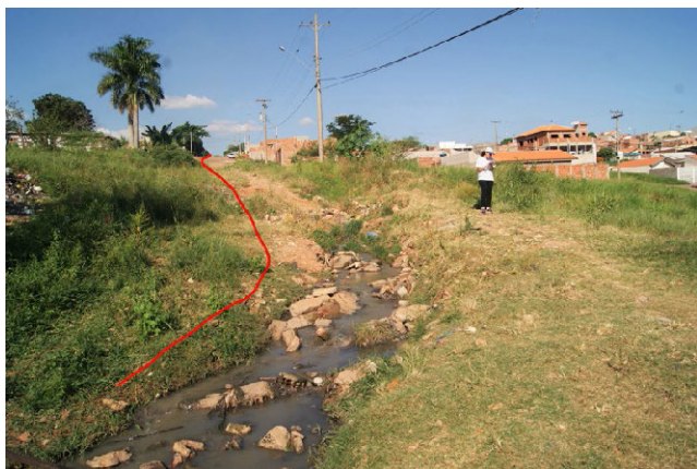
Figura 9. Aspectos da zona sul, com destaque para arruamento no sentido do declive (linha vermelha); destaque também para as características do solo (aspecto arenoso), ausência de cobertura vegetal (gramíneas esparsas) e escoamento superficial do esgoto.
