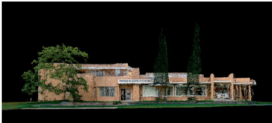
Figura 10: Elevación frontal mediante fotogrametría y estereofotogrametría
