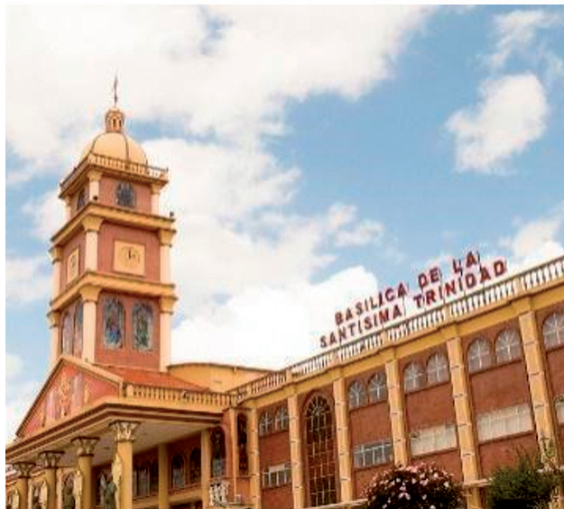
Figura 13. Fachada Basílica de la Santísima Trinidad (U.E.P.C.C)
