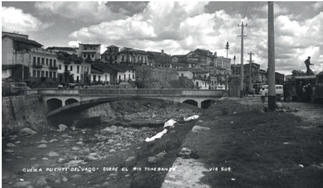
Figura 2. Cuenca Puente del "Vado" sobre el río Tomebamba vía sur, 1953
