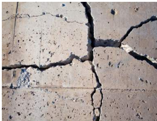
Figura 2. Agrietamiento
