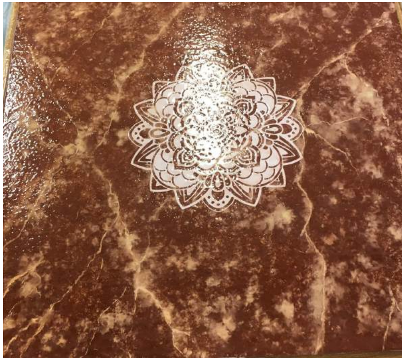
Figura 29. Reacción de pintura epóxica con productos base aceite
