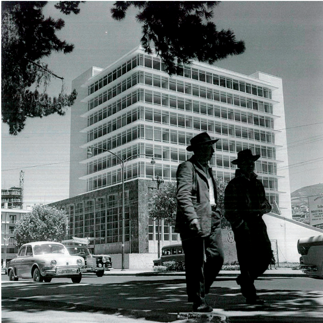
Figura 2. Edificio de la Caja del Seguro Social
