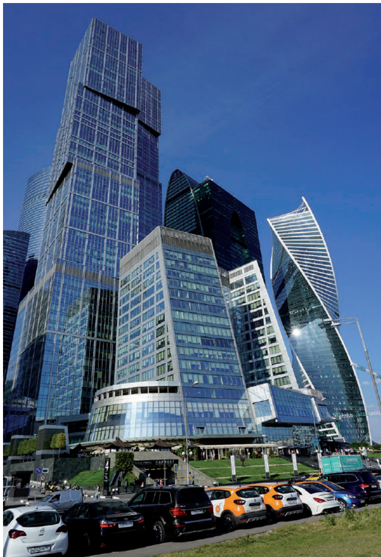
Figura 3. Moscú con parte de su postmodernidad: Moscú City
