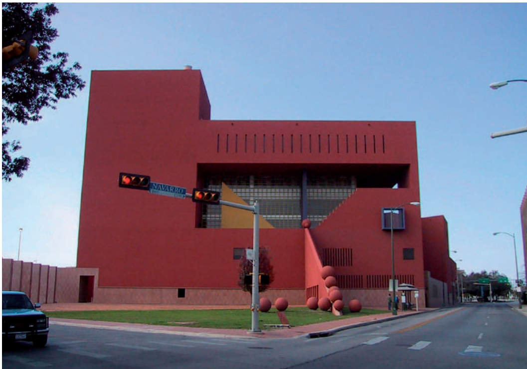
Figura 5. Biblioteca pública en San Antonio Texas
