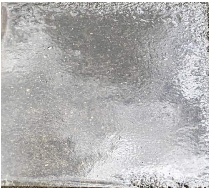
Figura 33. Epóxico aplicado en hormigón
