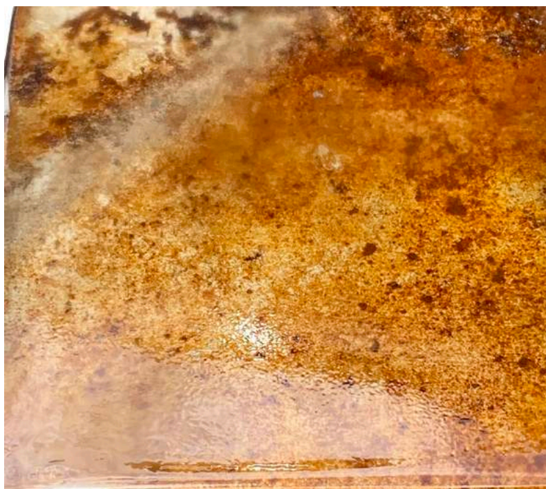
Figura 28. Epóxico aplicado en superficies corrosivas
