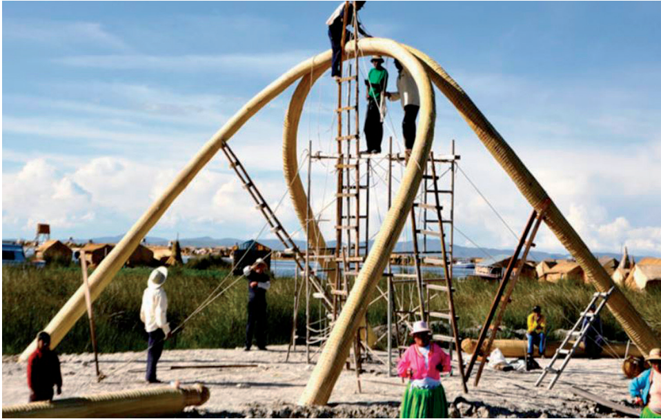
Figura 4. Proyecto totora, proceso de construcción. Fuente: Talavera, (2009).
