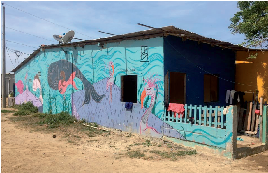
Figura 5. Vista desde el terreno donde se realizó el proyecto. Elaboración propia.
