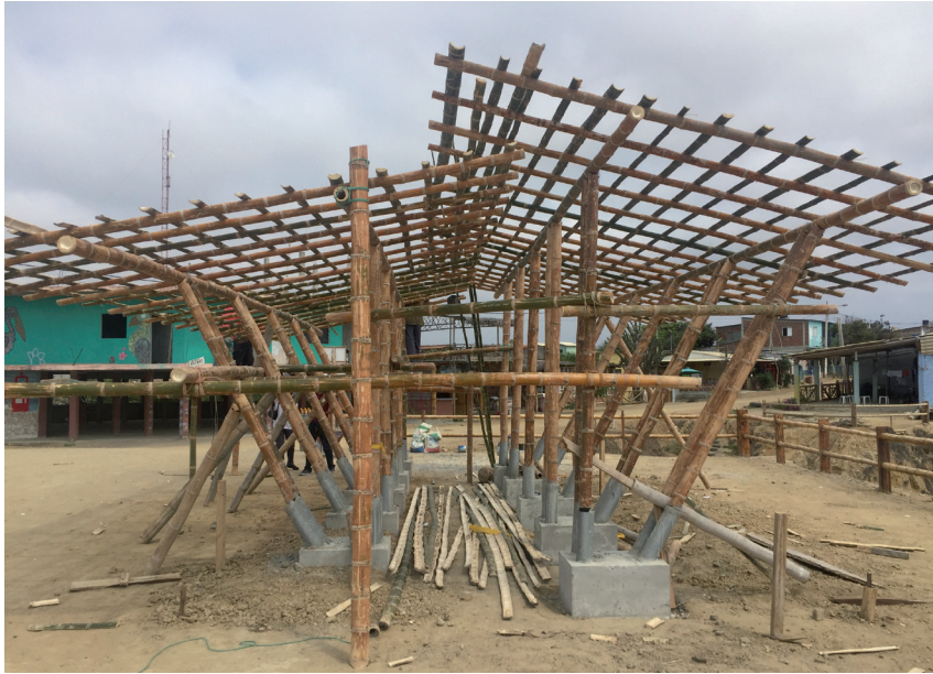
Figura 15 Avance de la colocación de cañas y estructura de cubierta de acuerdo al diseño arquitectónico Estudiante Fausto Amén inspeccionando unión de caña con base de hierro.
