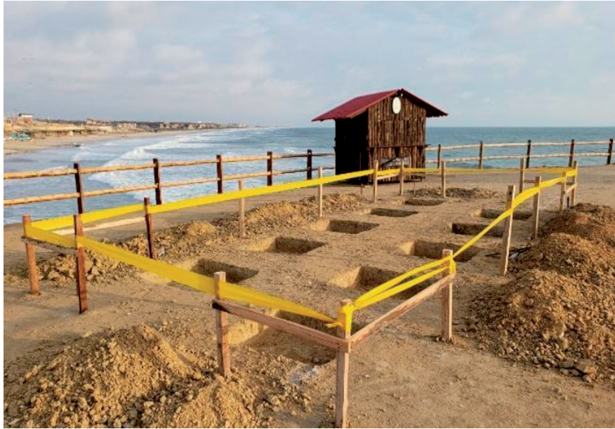
Figura 13 Replanteo General y espacios excavados para colocar plintos donde se fundieron. Fuente: Estudiantes de vinculación, (2018).
