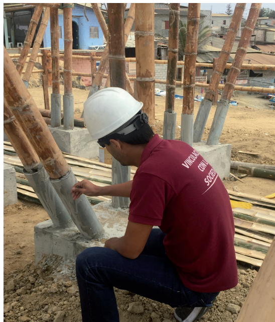
Figura 16. Avance de la colocación de cañas y estructura de cubierta de acuerdo al diseño arquitectónico. Estudiante Fausto Amén inspeccionando unión de caña con base de hierro.
