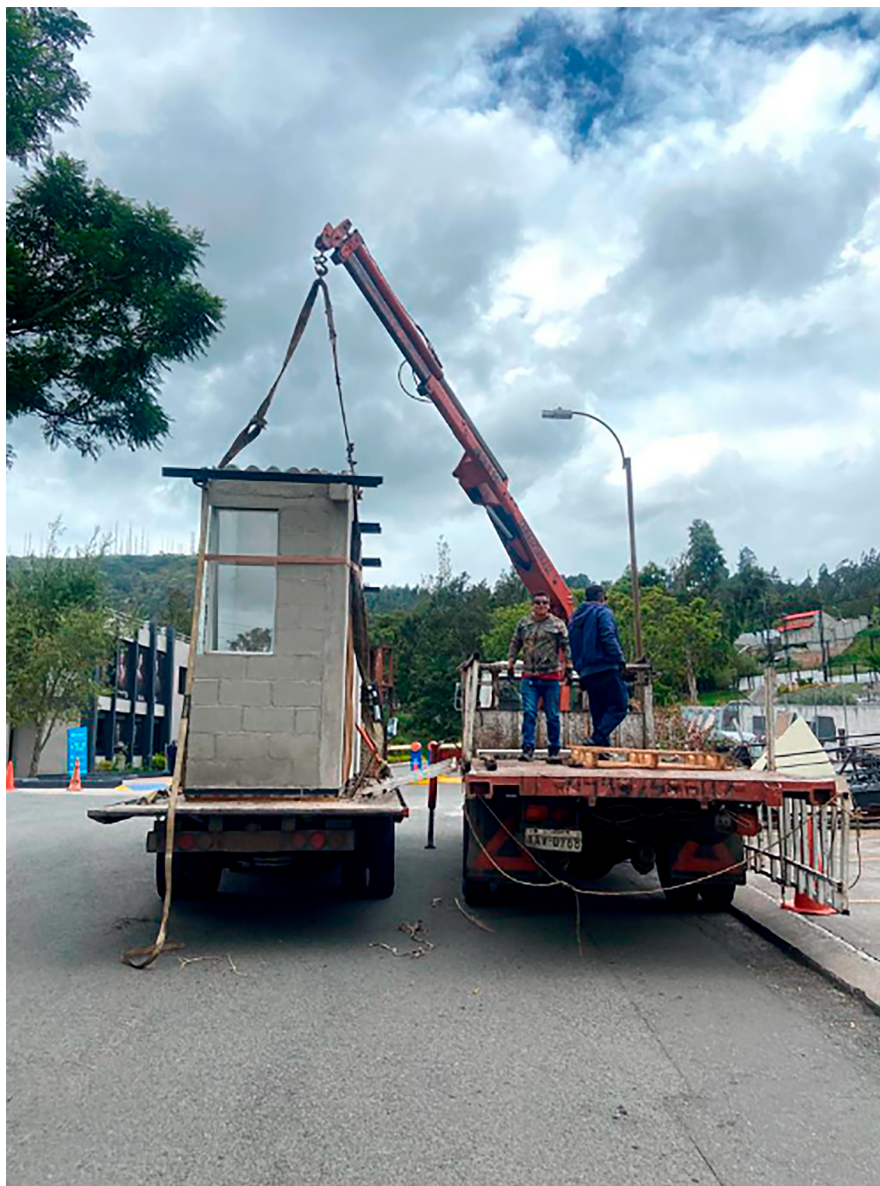
Figura 32. Sección constructiva Azuay- Transporte.
