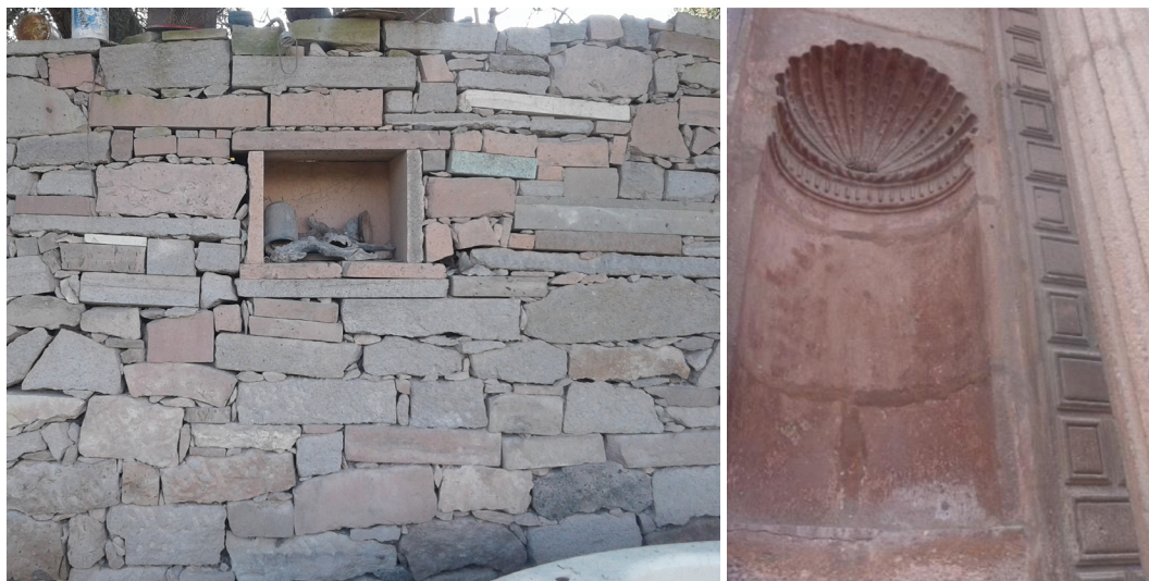
Figura 1 y Figura 2. Dos formas de construcción, en los templos de la ciudad y en las casas de la comunidad de Escalerillas, donde se transforma la cantera.
