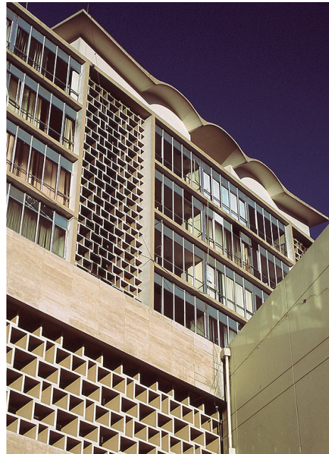
Figura 10. Vistas parciales del edificio (Ib.).
