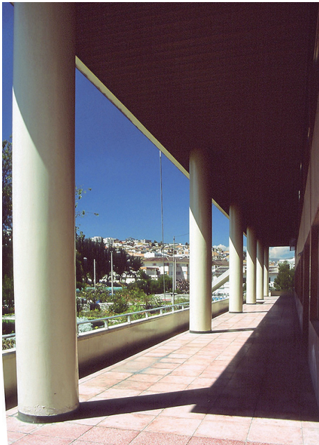
Figura 9. Vistas parciales del edificio (Ib.).
