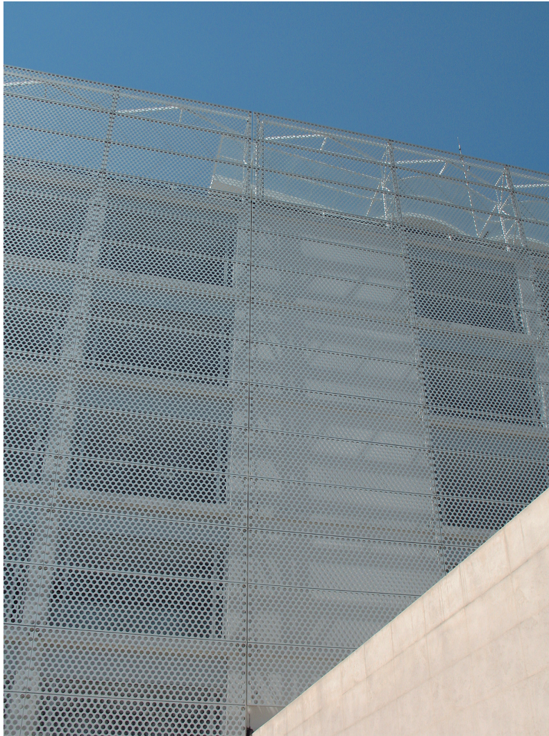
Figura 14. Vista en detalle de la malla que cubre al edificio (Ib.).
