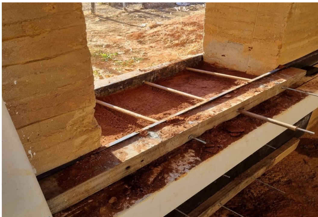
Figura 3. Construcción de ecoaldeas con tierra, material de construcción de bajo costo y no contaminante.
