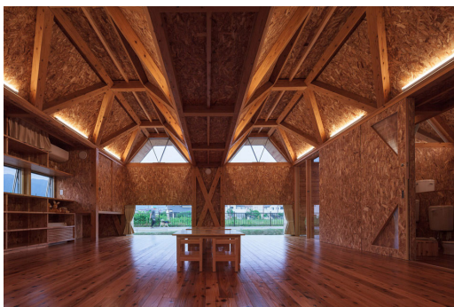
Figura 15. Uso de tableros OSB en la estructuración de paredes (Golenda, 2016).
