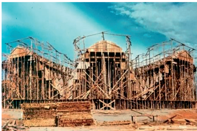
Figura 21. Encofrado del Casino de la Brigada No. 19 Napo, Coca, c. 1978.
