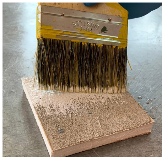
Figura 7. Aplicación de imprimante sobre hormigón
