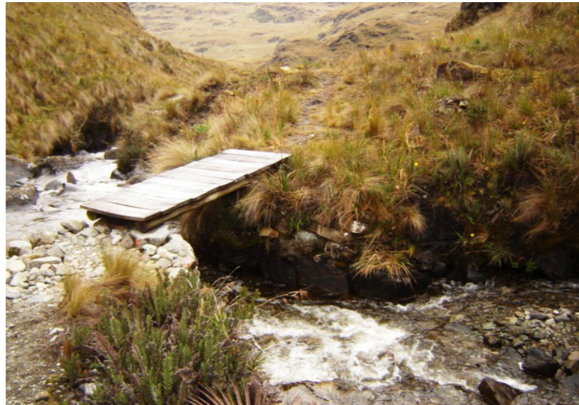
Fotografía N° 7 Tema: Mamamag, puente moderno sobre basamento inca. Fuente: Diego Suárez García
