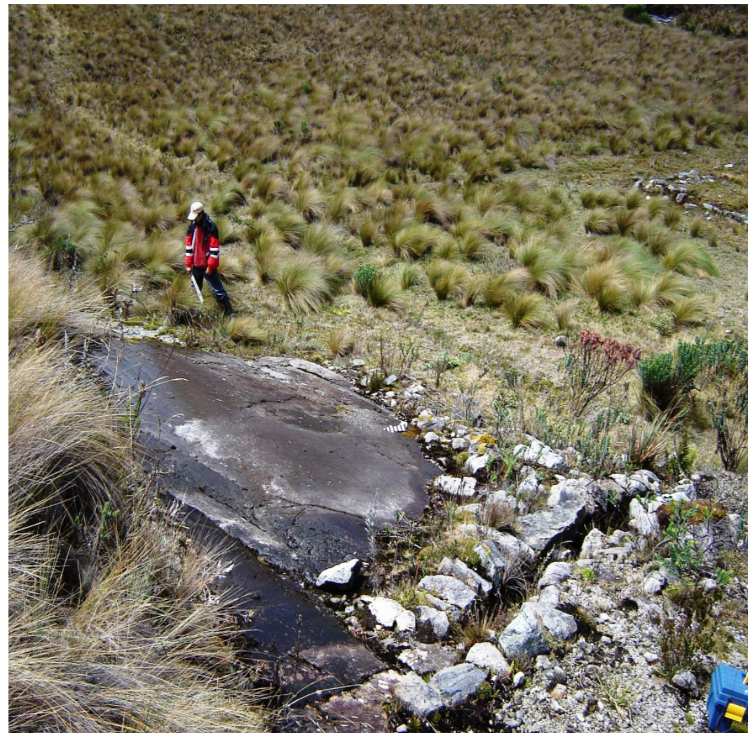
Fotografía N° 4 Tema: Tambo de Mamamag, drenaje o canal inca de piedra Fuente: Diego Suárez García
