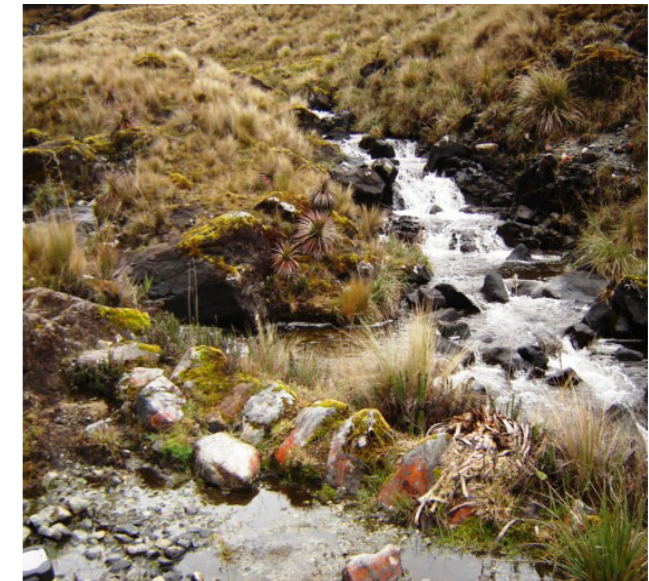
Fotografía N° 3 Tema: Mamamag : muro lateral de contención. Fuente: Diego Suárez García
