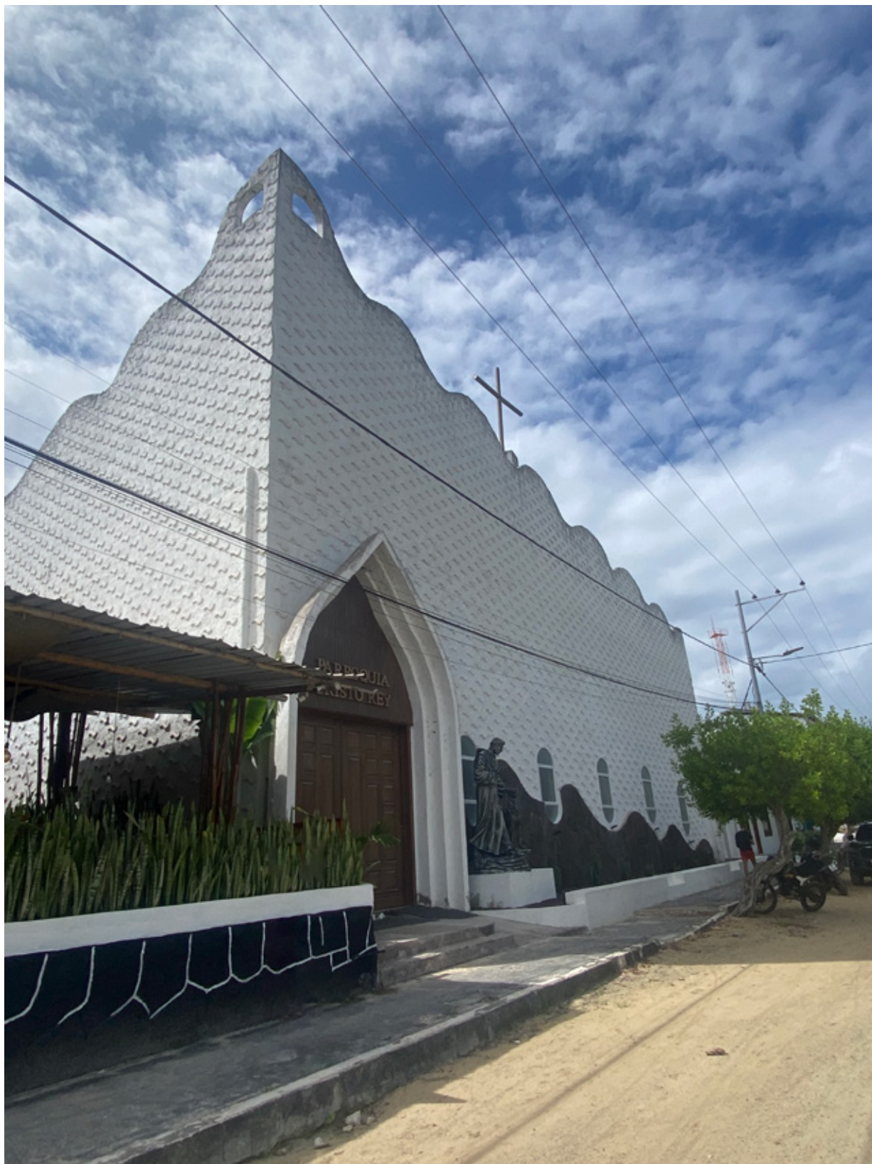
Fachada de la Iglesia Parroquial de Cristo Salvador, en el centro de Puerto Villamil
