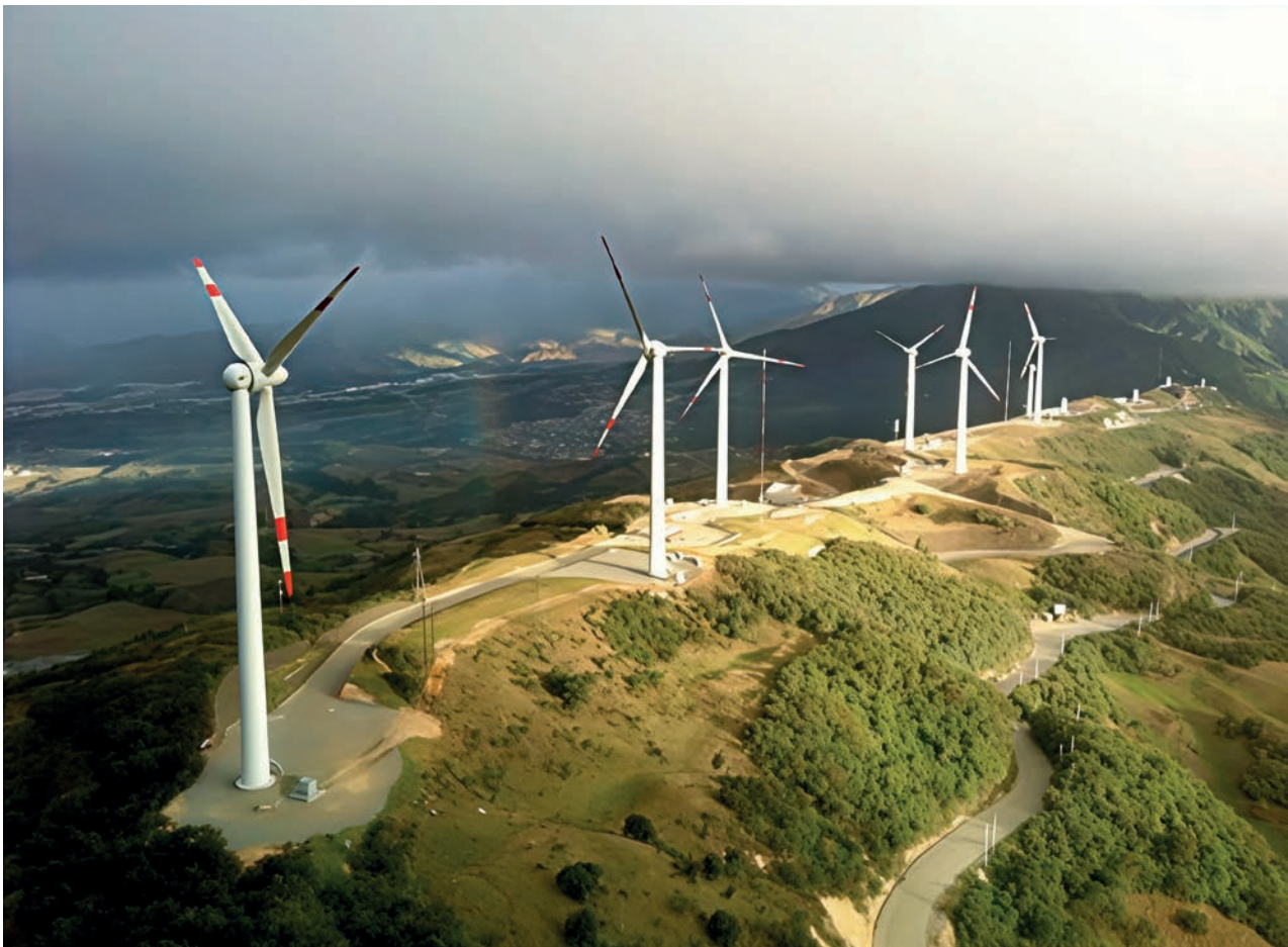
Central Eólica "Villonaco", Loja
