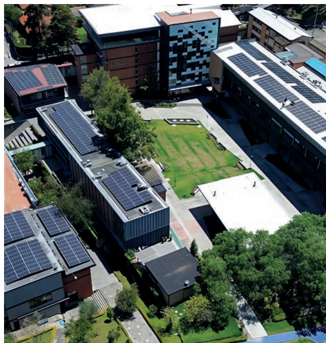
Instalación de paneles fotovoltaicos en edificios de la Universidad del Azuay. Instalación de 530 kWp.
