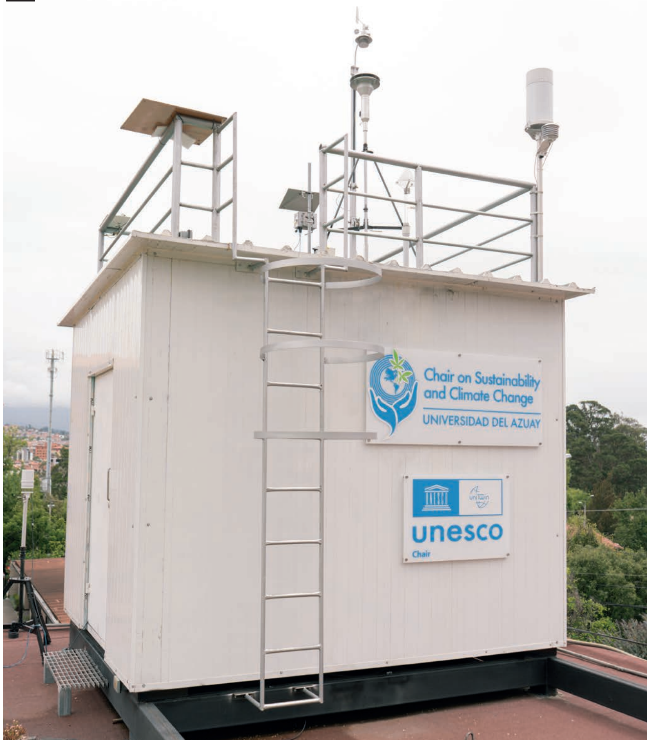
Estación de monitoreo del aire, Campus UDA
