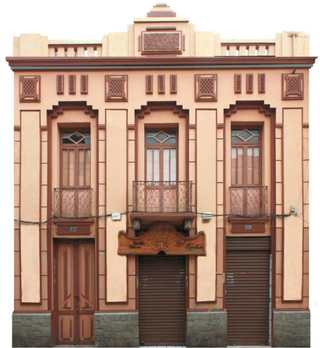
Estilo art déco en Cuenca, Borrero 7-60 entre Sucre y President Córdova Fuente: Ochoa, P. et al. El patrimonio edificado de Cuenca N° 2 , 2017
