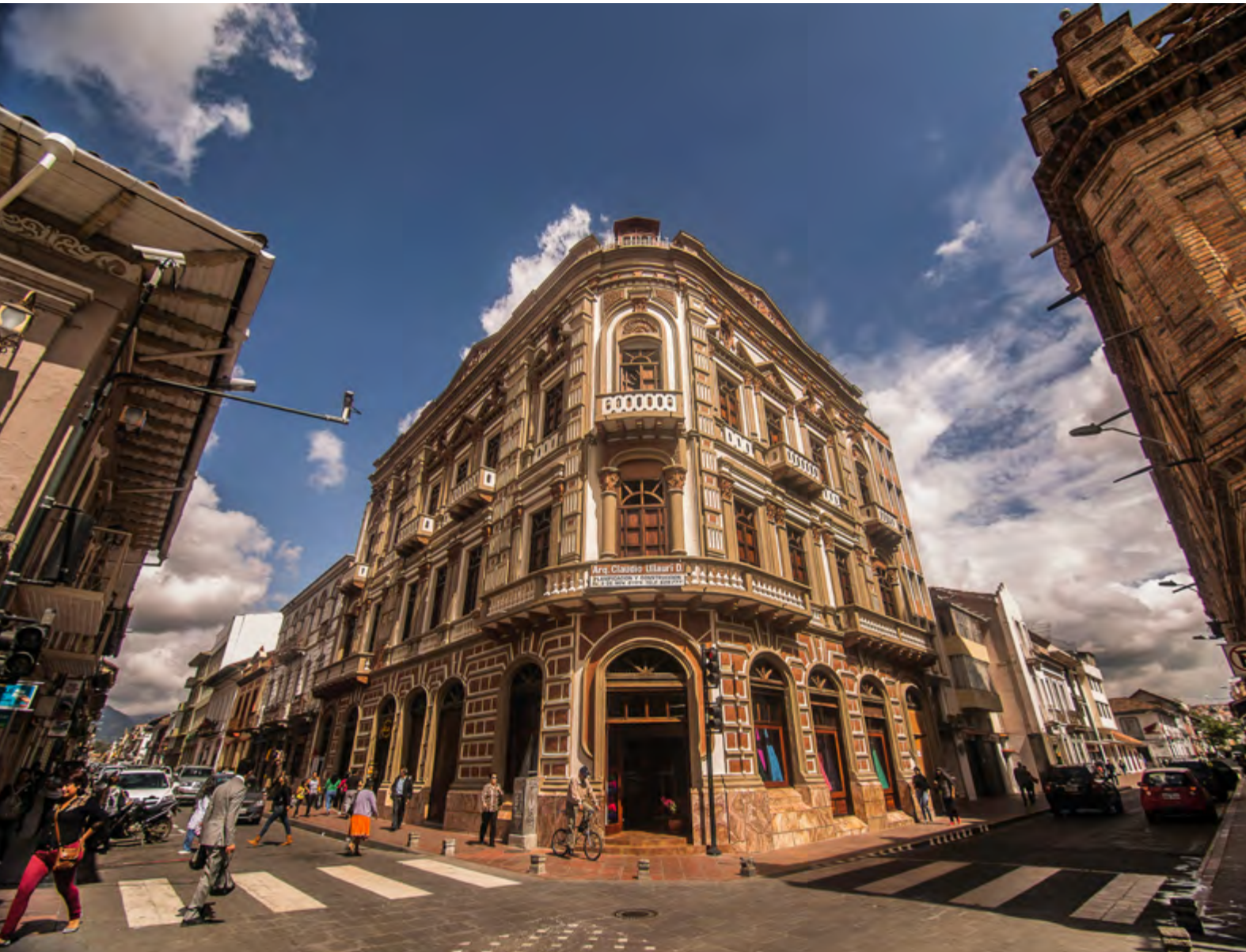
Edificio San Agustín, calles Padre Aguirre y Sucre, construcción 1932. Foto: Juan Carlos Astudillo
