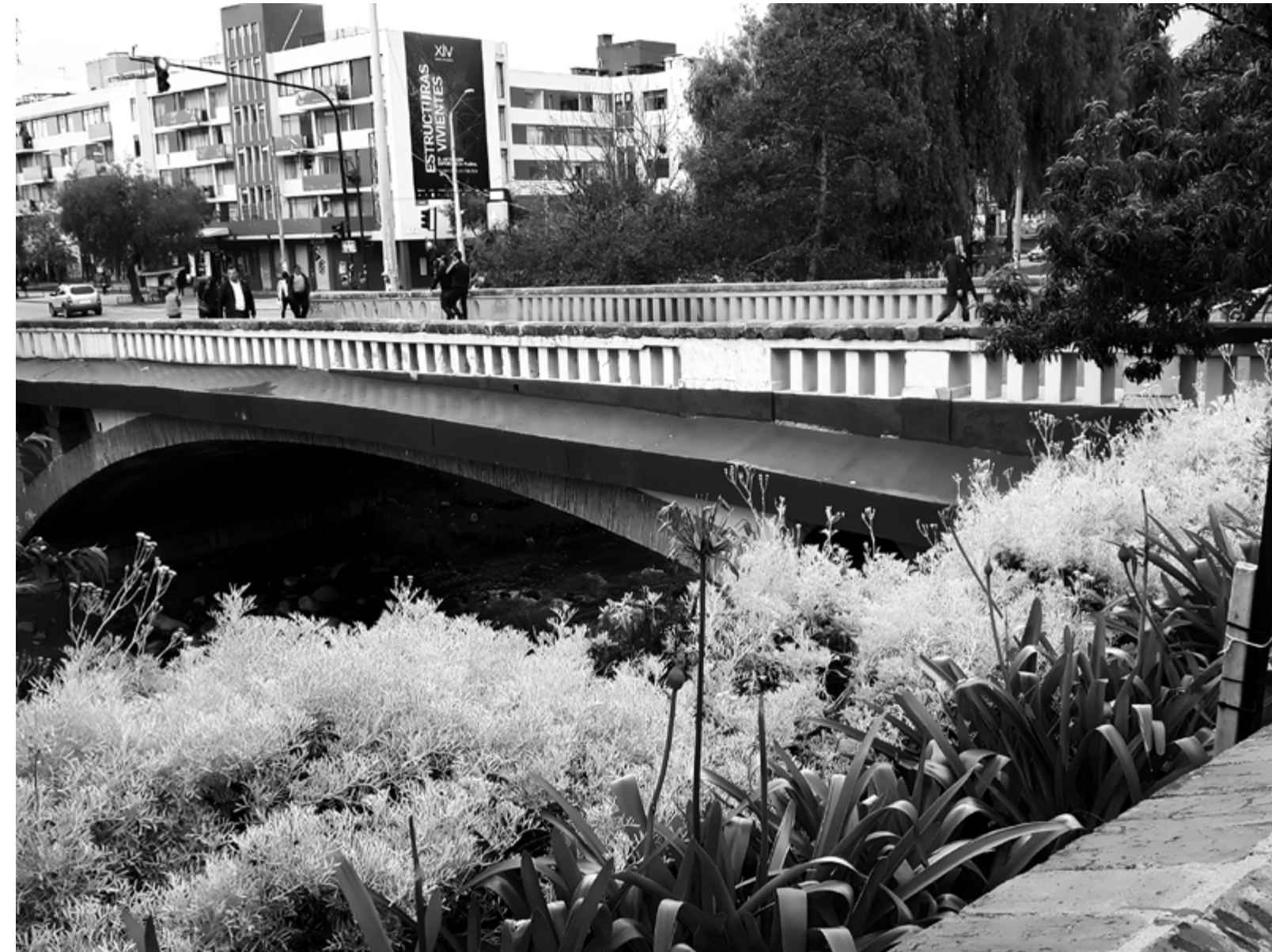
Puente del Centenario, noviembre de 2018. Foto: Juan Cristóbal Mac Lean E.
