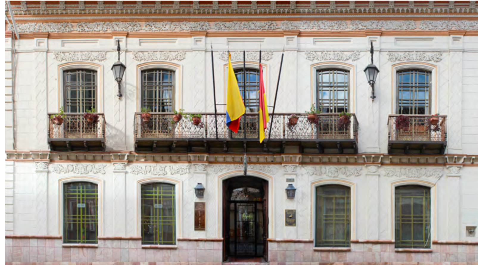
Estilo neoclásico francés en Cuenca, Bolívar 12-55 entre Juan Montalvo y Tarqui Fuente: Ochoa, P. et al. El patrimonio edificado de Cuenca N° 2 , 2017
