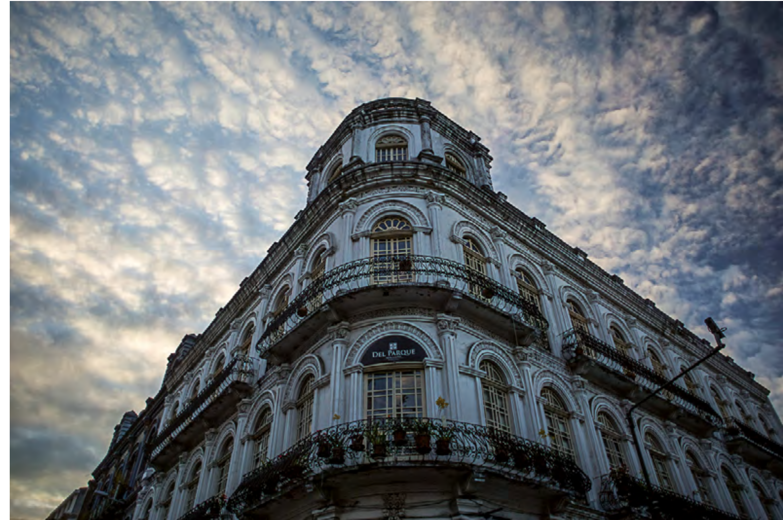
Casa Montesiños-Arce, calles Benigno Malo y Bolívar. Arquitecto: Juan Bautista Stielhe, construcción 1898-1907. Foto: Juan Carlos Astudillo
