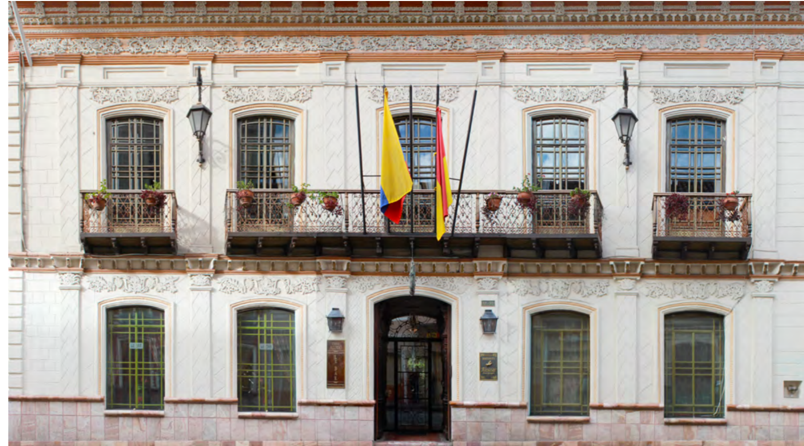
Estilo neoclásico francés en Cuenca, Bolívar 12-55 entre Juan Montalvo y Tarqui Fuente: Ochoa, P. et al. El patrimonio edificado de Cuenca. Registro gráfico n° 2 , 2017
