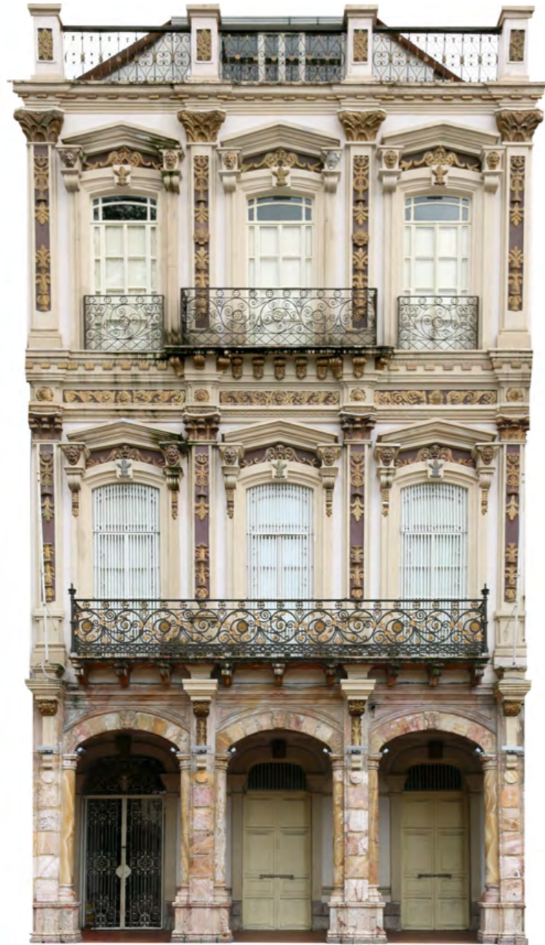
Estilo neoclásico francés en Cuenca, Bolívar 8-28 entre Luis Cordero y Benigno Malo Fuente: Ochoa, P. et al. El patrimonio edificado de Cuenca. Registro gráfico n° 2 , 2017
