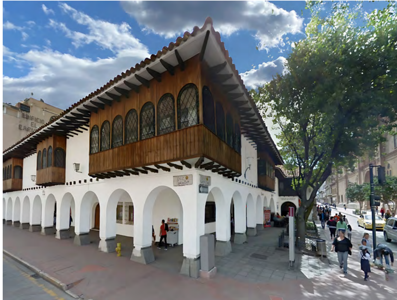
Edificio ganador de la preselección Gil Ramírez Dávalos en 1971, obra de Patricio Muñoz Vega. Esquina de las calles Sucre y Benigno Malo. Fuente: Google Maps, 2022
