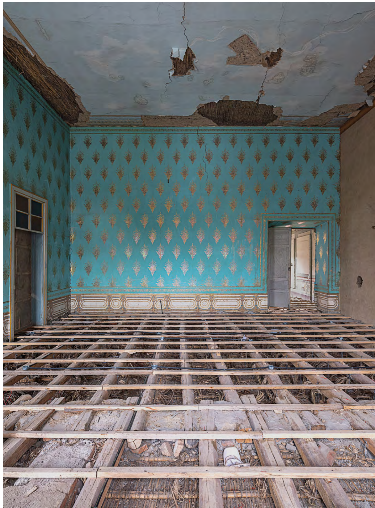
La Mansión Matilde en proceso de restauración, calles Luis Cordero y Bolívar, noviembre 2018. Foto: Leyla Cárdenas
