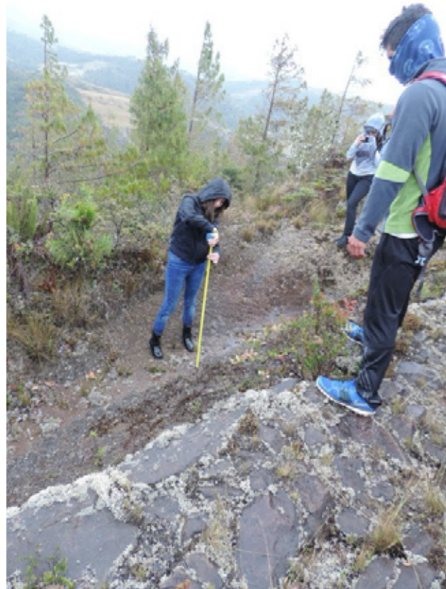
Figura. Calzada en excelente estado de conservación a un metro de alto del suelo
