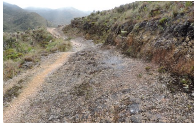
Camino de 4 metros de ancho de roca natural y corte de talud lateral
