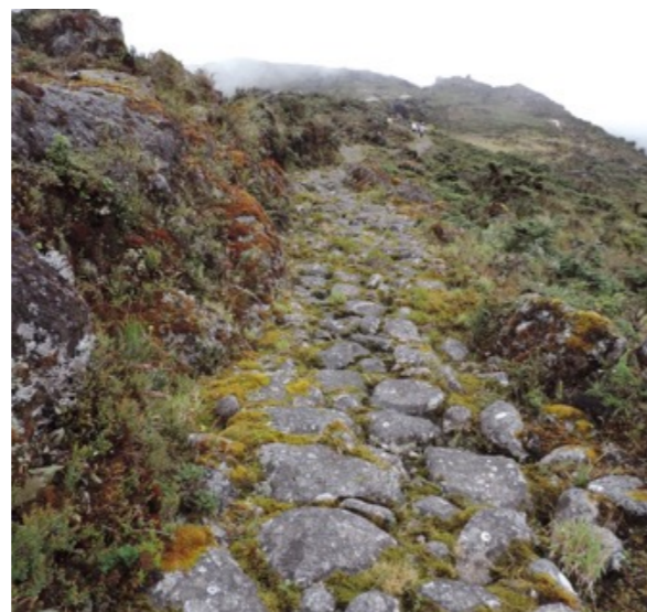
Camino de 2 metros de ancho protegido de hileras de piedra y taludes
