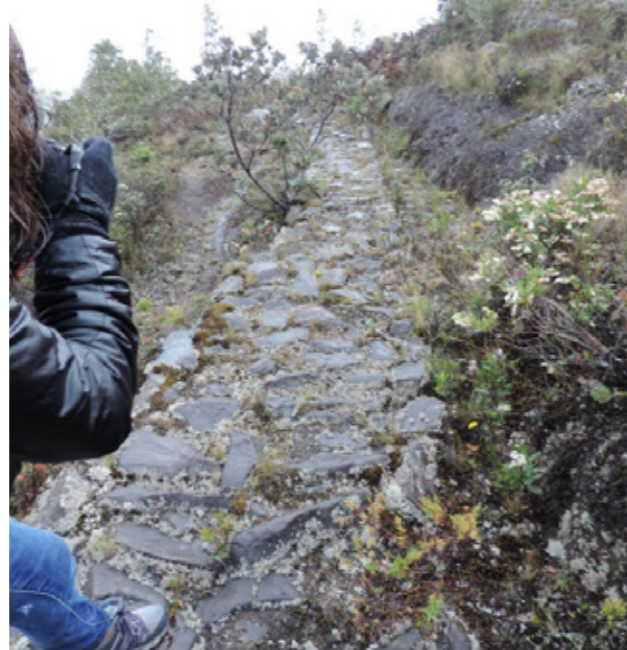
Figura. Camino empedrado con un corte de talud de roca y canal lateral
