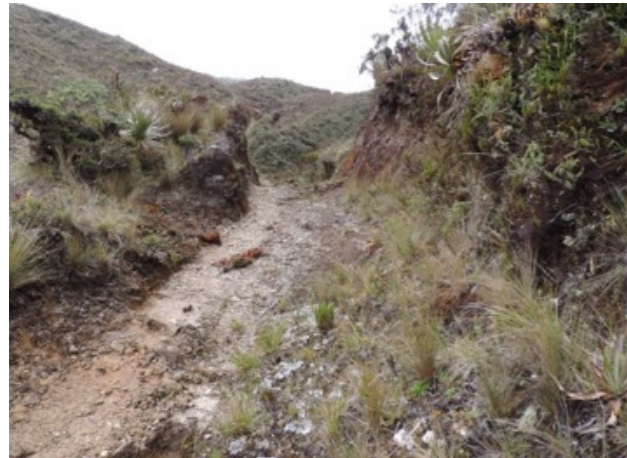
Camino excavado en roca natural y protegido por cortes de talud lateral
