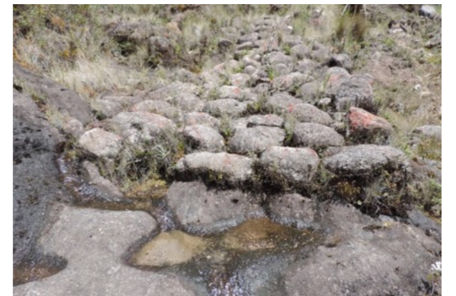
Figura. Perspectiva de la técnica de construcción del empedrado cimentado sobre cunetas excavados en el afloramiento rocoso
