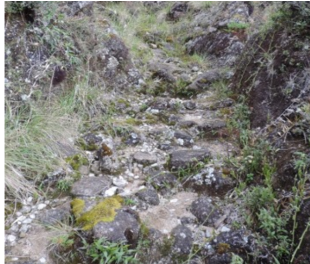
Camino empedrado y sistema de graderías protegidos por taludes laterales
