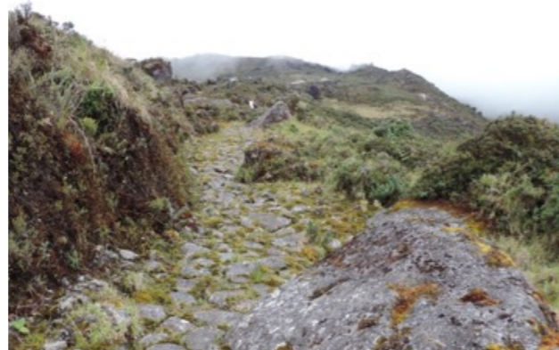
Reducción del ancho del camino por monolitos in situ
