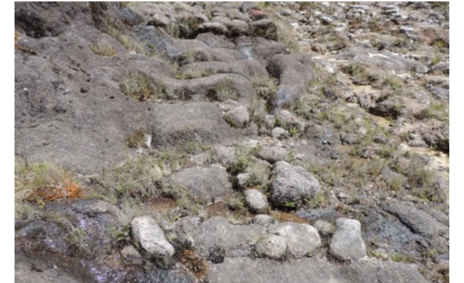
Figura. Evidencia de la técnica de construcción del camino a través de la excavación de pequeñas cunetas en el afloramiento rocoso para la cimentación del empedrado
