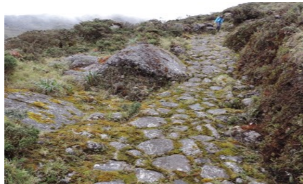
Piedras planchas transportadas y acomodadas conforman el empedrado del camino y talud lateral
